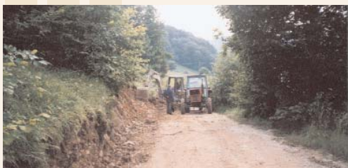
KS Šentrupert pri posodabljanju krajevnih cest št. 700 731 Šentrupert–Trojni Dol. Trasa, dolga 1 km, se pripravlja za asfaltno prevleko. Ta krajevna cesta se navezuje na KS Kalobje v Občini Šentjur.
