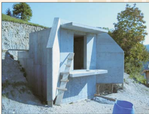
12 m 3 rezervoar nad Tevčami
