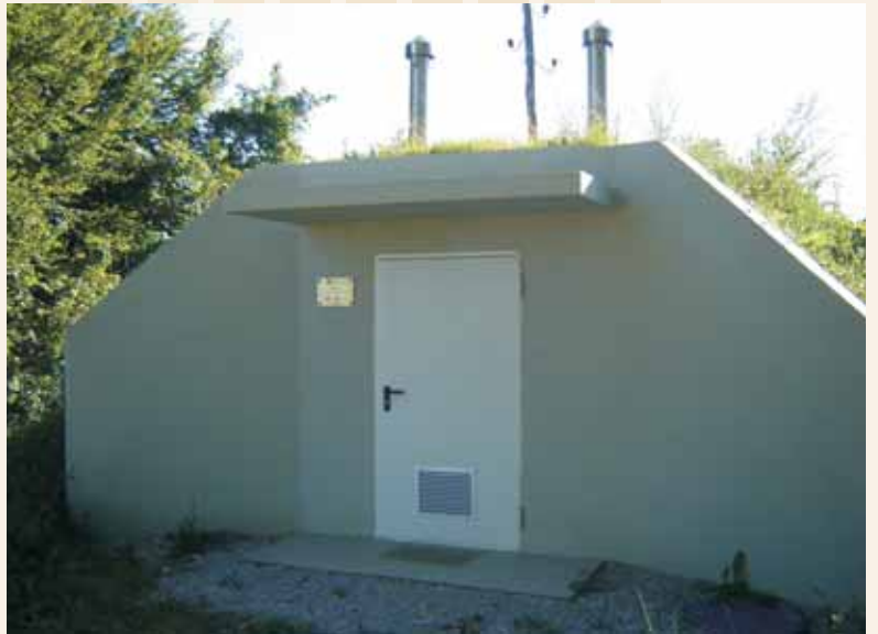
Vodohran Šempeter (12 m 3 ) in vodohran na Vrhu nad Laškim (50 m 3 ), zgrajena 2009
