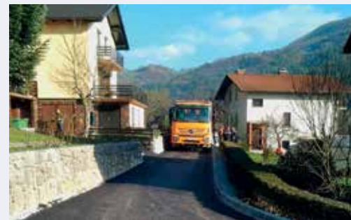
Izvajanje kanalizacije in ostale infrastrukture na območju Debra.
