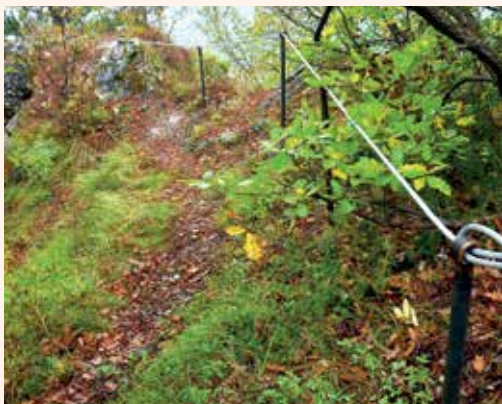
Urejeno varovanje z jeklenico prepadne udorine
