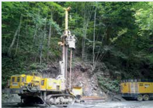
Vrtalna garnitura na območju vodnih virov Trije studenci nad Jurkloštro.
