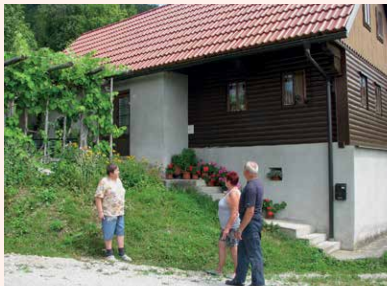
Bronislava se z veseljem ozira po novi strehi, ki odslej ne bo več puščala
