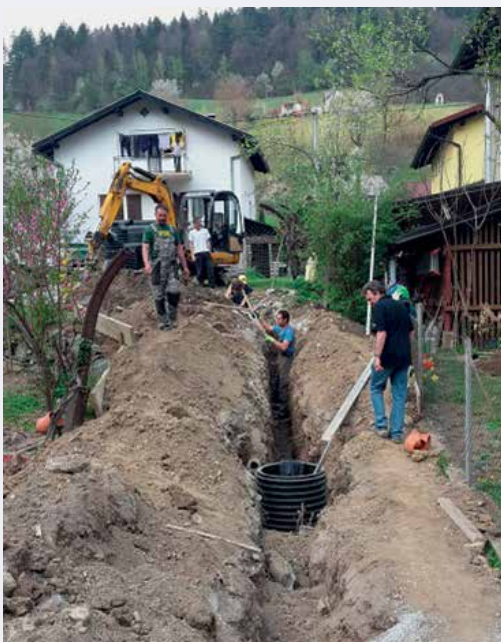
Izvedba infrastrukture na Keršetovi ulici.
