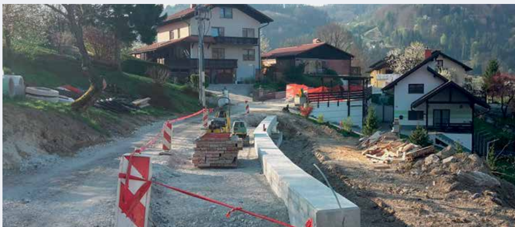
Sanacija plazu na Lahomšku.
