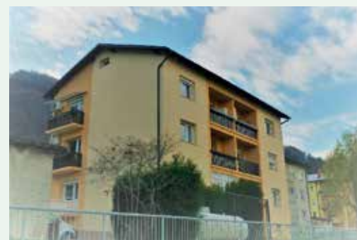
Zdraviliška cesta 27 v Rimskih Toplicah pred in po sanaciji
