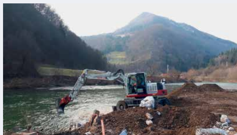
Pričetek del za obrežne temelje in začasno nasutje v Savinji
