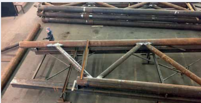
Priprava nosilne konstrukcije kolesarske brvi v proizvodnih objektih.
