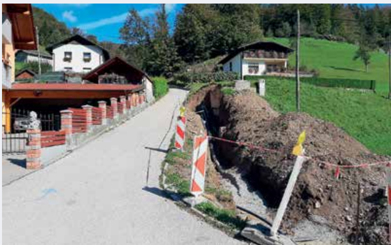
Gradbišče v Hudi Jami
