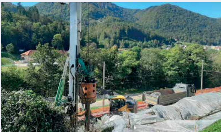
Gradbišče nadomestne ceste na Globokem
