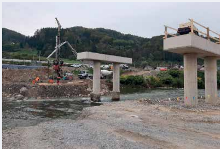
Izgradnja mostu preko Savinje: v izvajanju so dela izgradnje pomožnih temeljev in temeljenje za vmesno podporo v reki Savinji.
