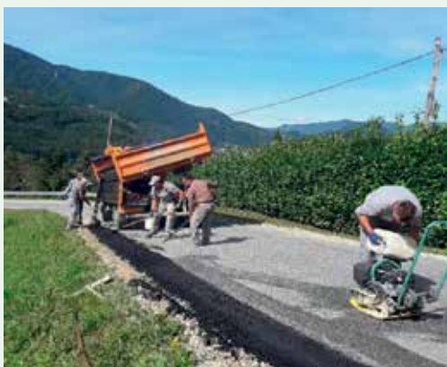
Izdelava asfaltnih muld
