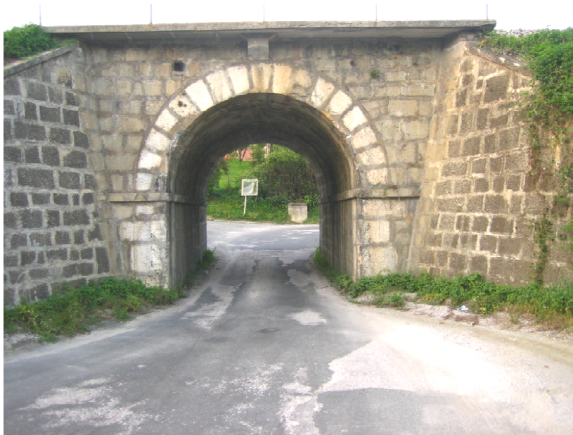
Slika 1: Obstoječ kamniti obokani podvoz pod elektrificirano dvotirno železniško progo
