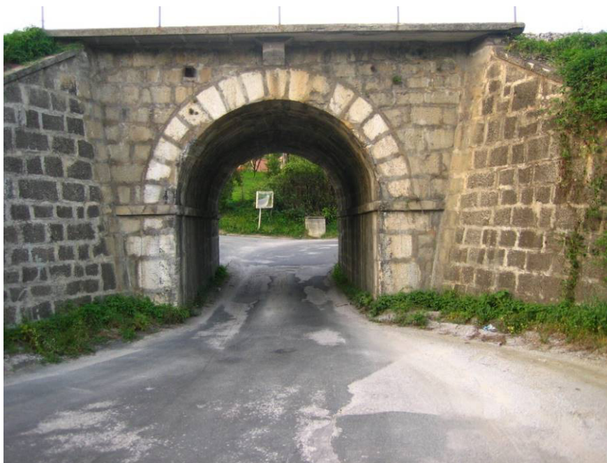
Slika 1: Obstoječ kamniti obokani podvoz pod elektrificirano dvotirno železniško progo
