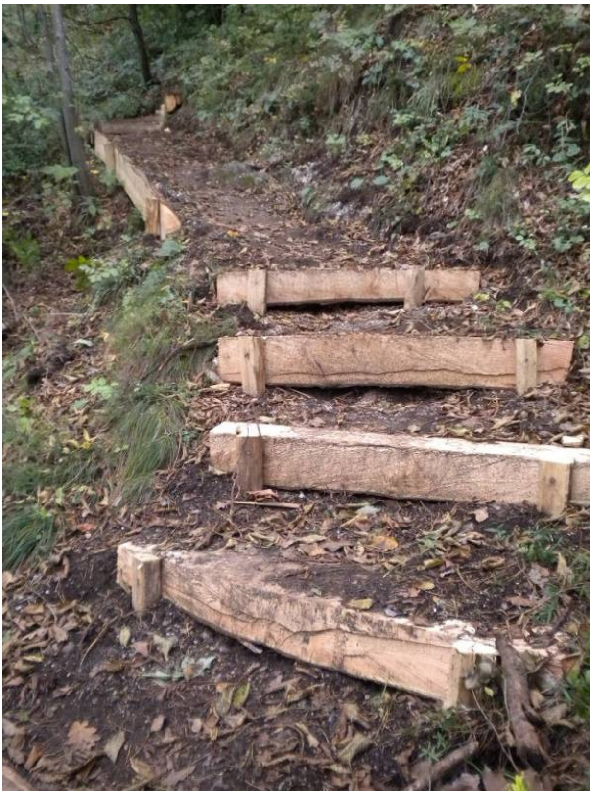
SLIKA 19: primer ureditve erozijske zaščite
