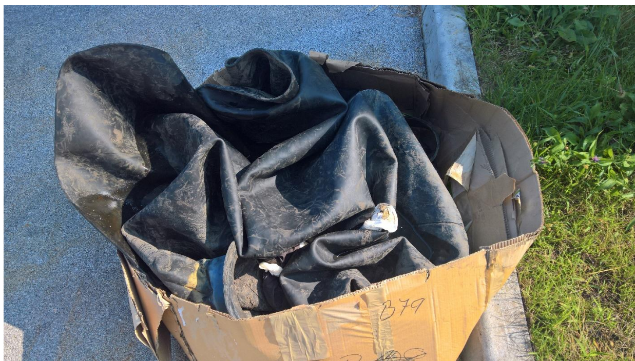
- menjava membrane tlačne posode Reflex (dve sliki)
