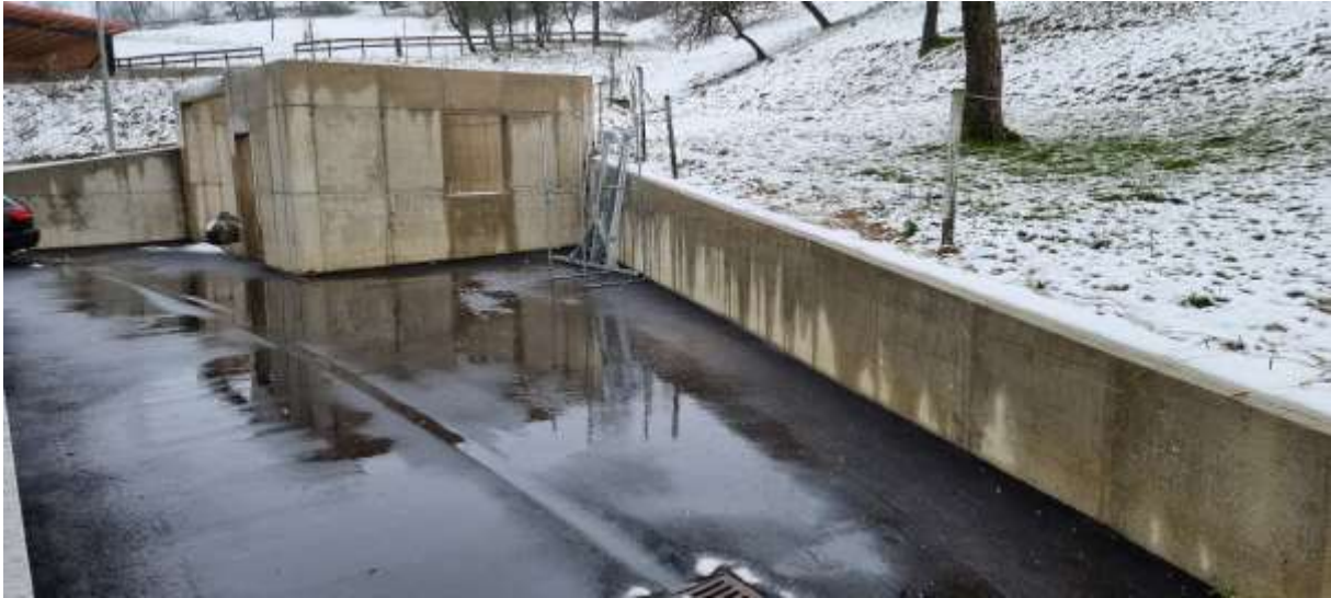
Slika 10: AB oporni zid s konstrukcijo garaže in asfaltirano transportno potjo
