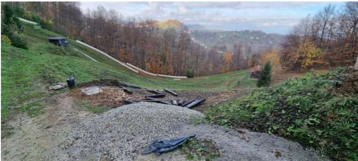
Slika 2: Izgradnja vzpenjače in planiranje za pripravo smučišča
