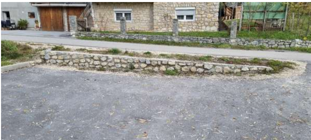
Slika 5: Kamniti oporni zid
