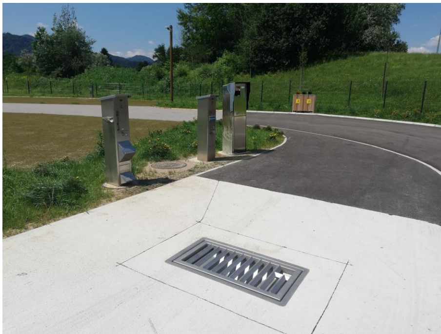
Slika 6: Primer ploščadi s talno rešetko in stebričkom za odpadne vode
