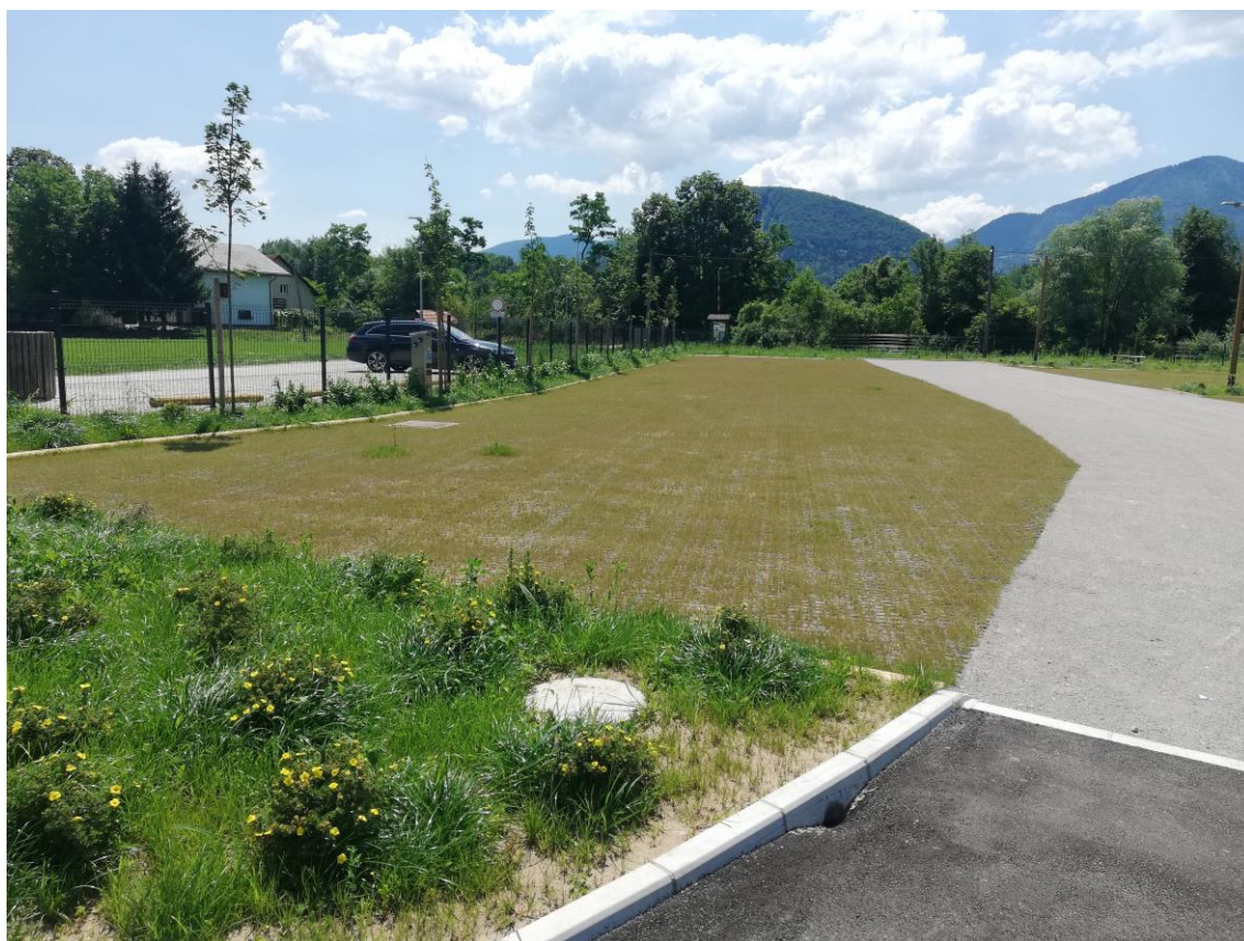
Slika 4: Primer urejenega parkirišča za avtodome – asfaltiran cestni priključek, makadamska dovozna cesta, zatravljeni parkirni prostori, utrjeni s travnimi ploščami.
