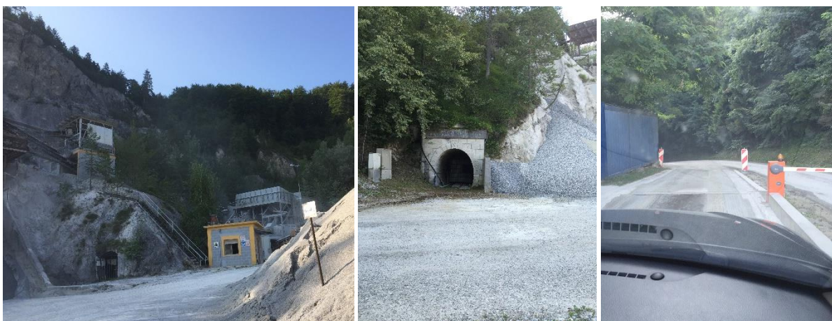
Slika 6: Obstoječi objekti v kamnolomu, rov v opuščeni rudnik, tehtnica
