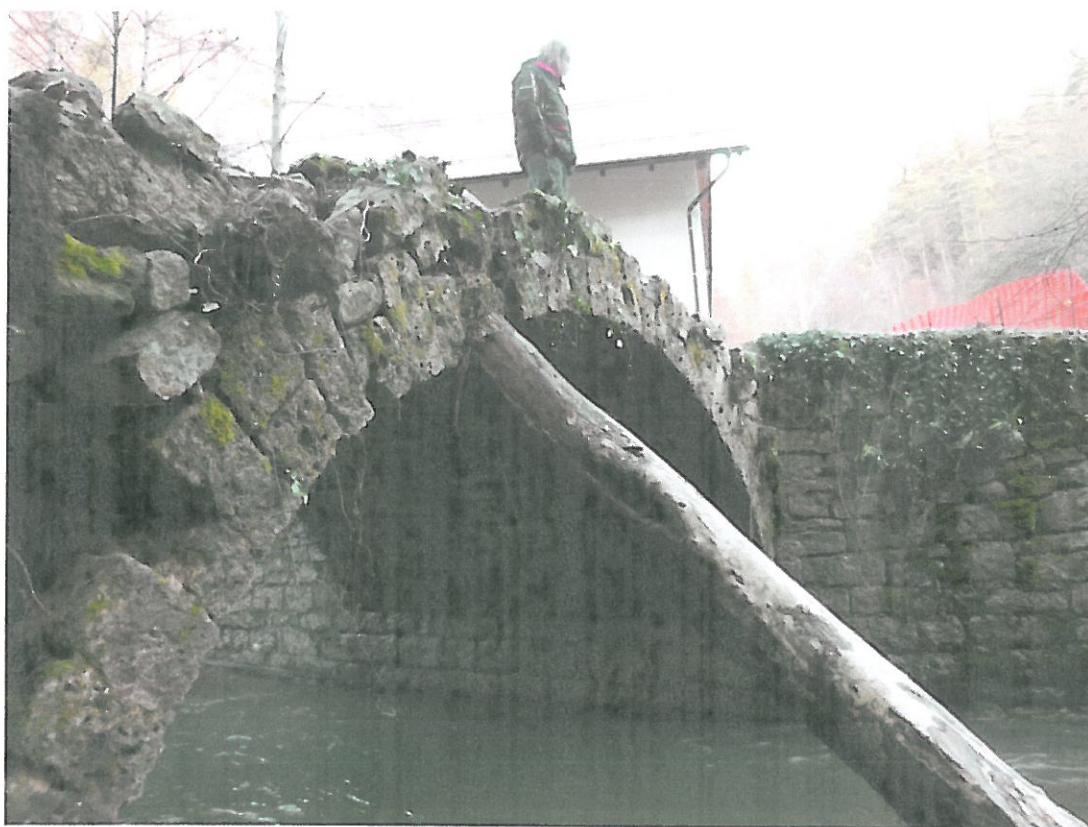
Poškodbe na kamnitem loku in na bočnih zidovih
