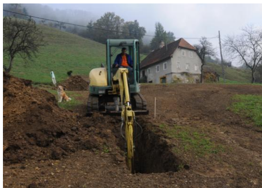
Foto 7: Sondiranje, izkop za sondažni jašek SJ-2
