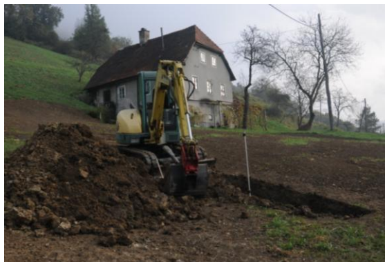
Foto 5: Sondiranje, izkop za sondažni jašek SJ-1
