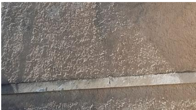
Slika 4: Neizoliran ovoj stavbe
