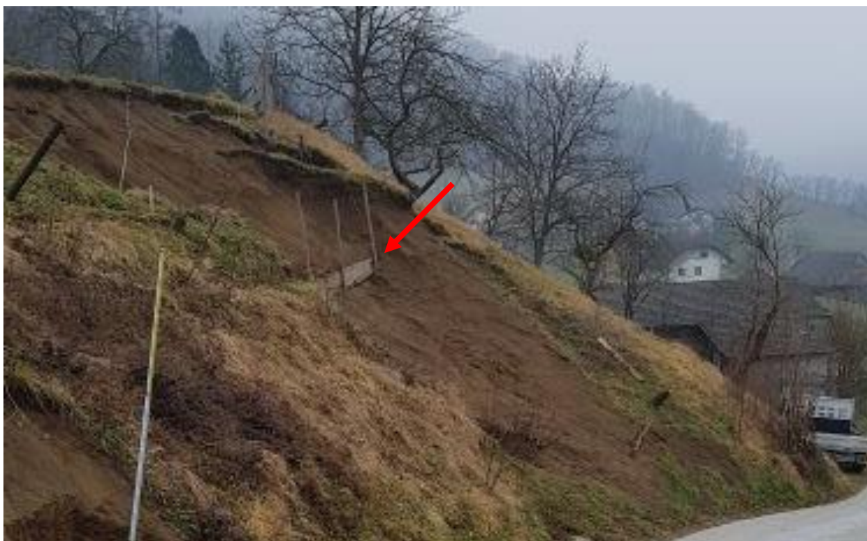
Slika 5: Zaščita vodovoda, 17.januar.
