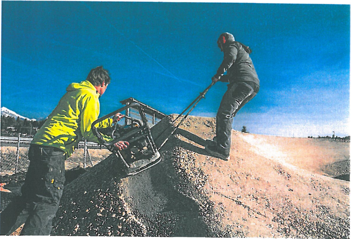
Slika: prikaz utrjevanja tamponskega drobljenca na zavojih
