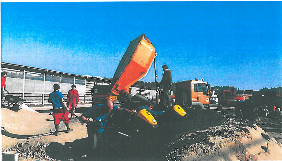
Slika: prikaz vgradnje asfalta na poligonu
