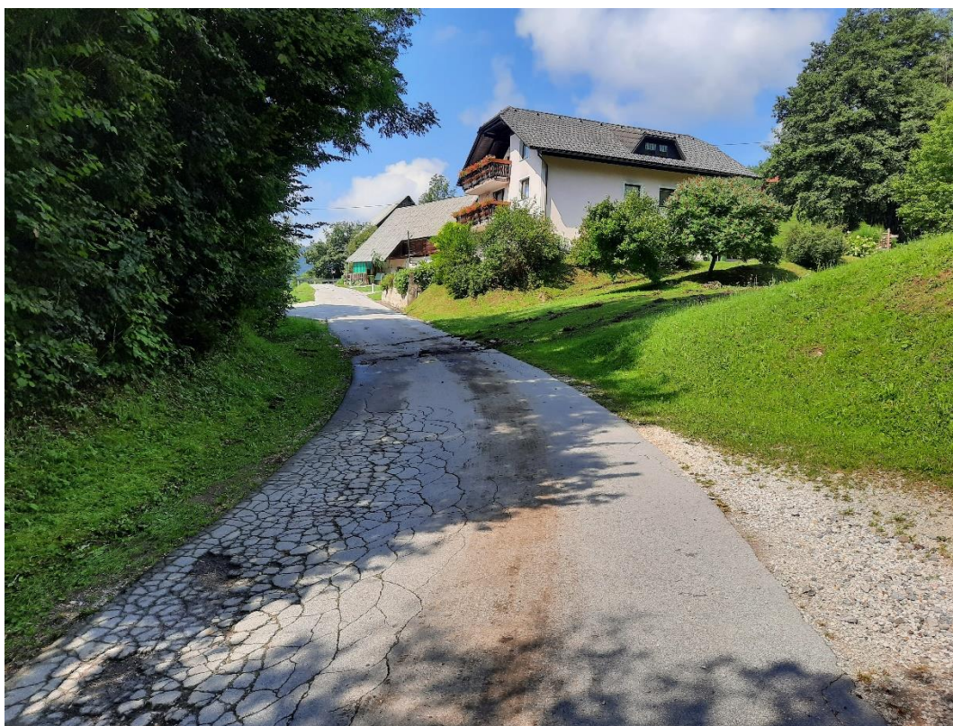
Slika 6: Poškodbe na LC med dvema propustoma
