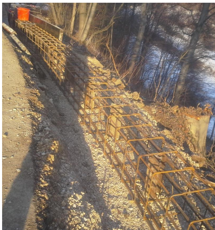
Slika 24 in 25: Izkop zaseka in zabijanje tirnic, postavitve armature
