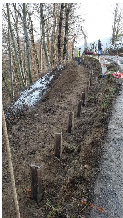
Slika 24 in 25: Izkop zaseka in zabijanje tirnic, postavitve armature
