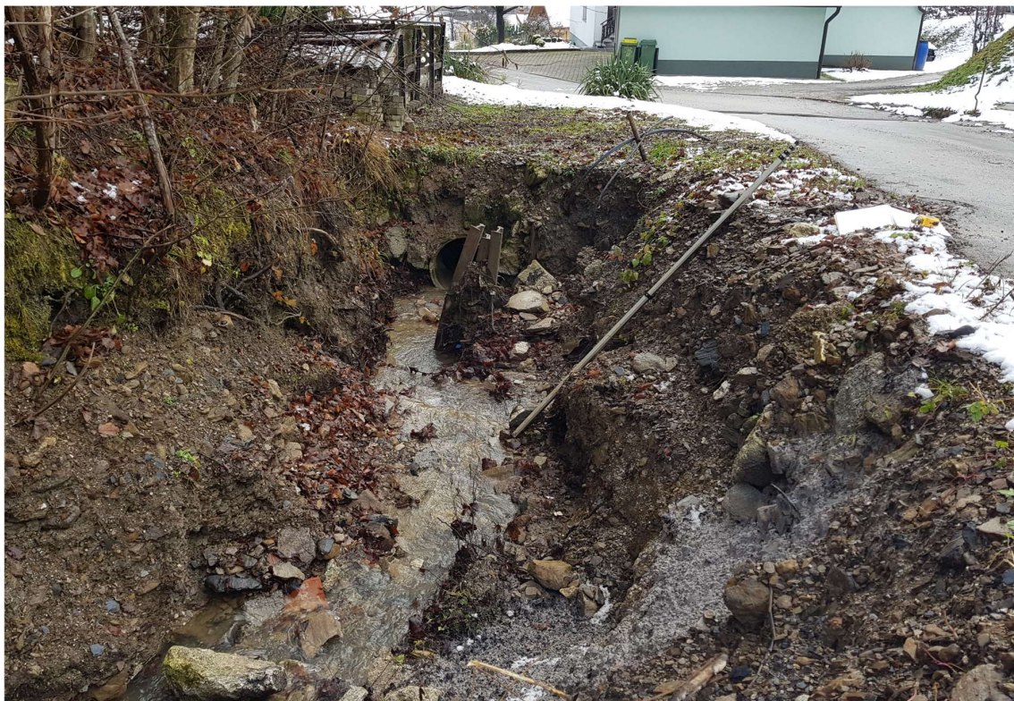
Slika 3: Zamašen prepust med neurjem in nestabilne brežine pod JP.
